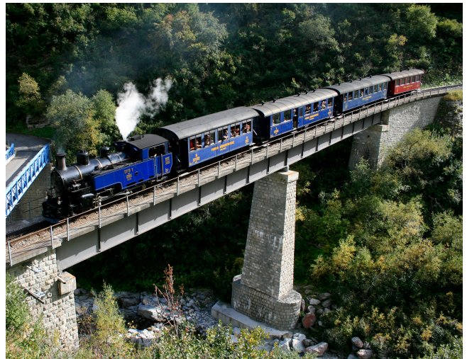
Foto dfb Wylerbrücke bei Realp
