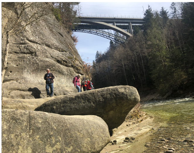
Schwarzwasserbrücke von unten
