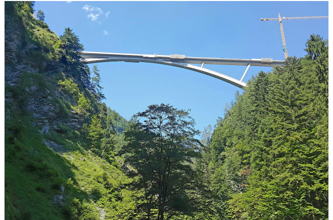
Die neue Taminabrücke Foto Eva Krätzer
